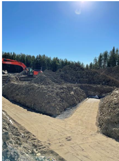
Ledningsschakt mot kondensbrunn nr.2
