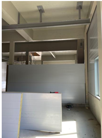
Montage innerväggar VVX-rum
