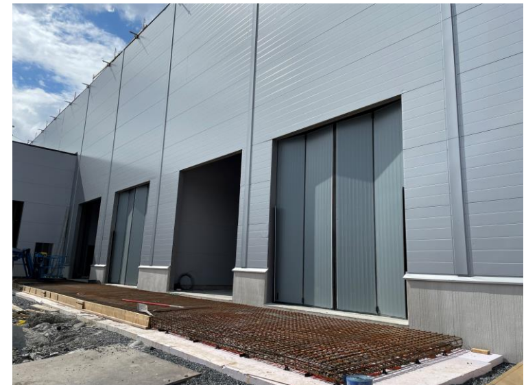
Armering av utvändiga plattor
