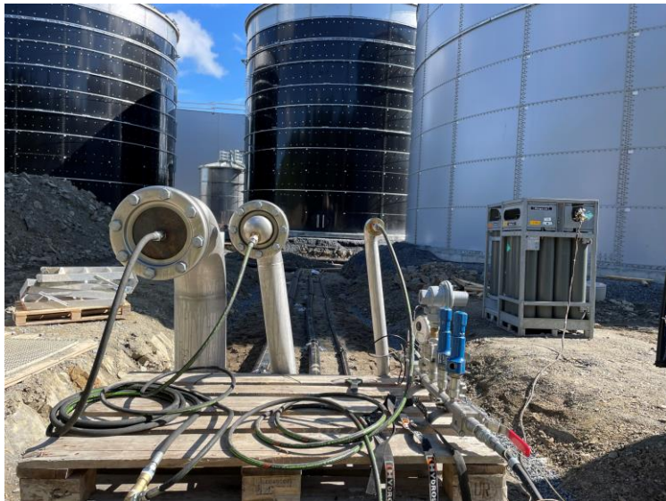
Trycktest av gasledningar
