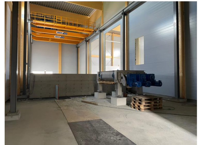
Utmatningsficka i travershall
