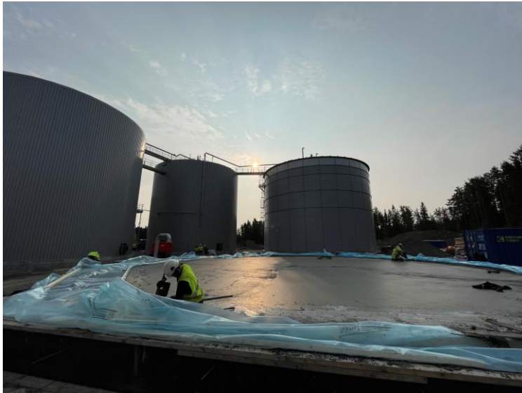
Betongarbeten på fundament för gasklocka
