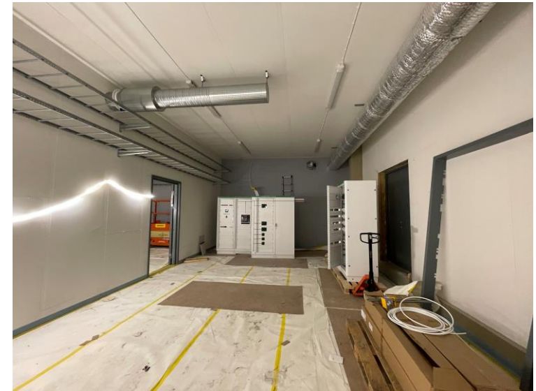
Installationsarbeten i elrum process plan 2
