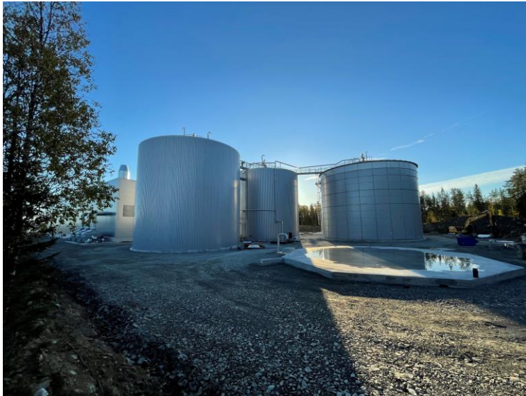
Fundament för gasklocka
