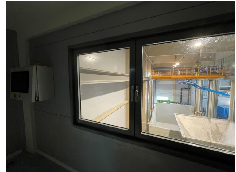
Manöverrum ut mot travershall
