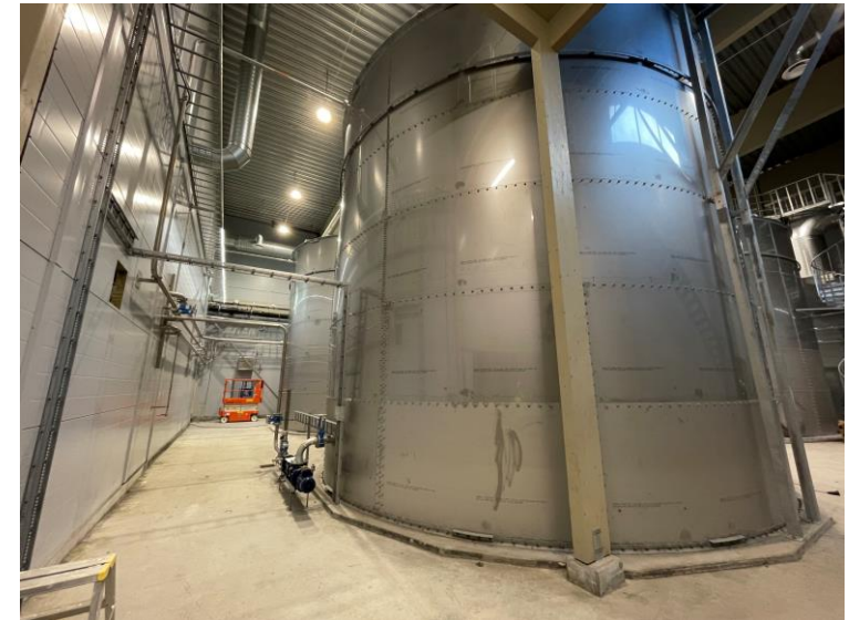
Invändig bufferttank flytgödsel
