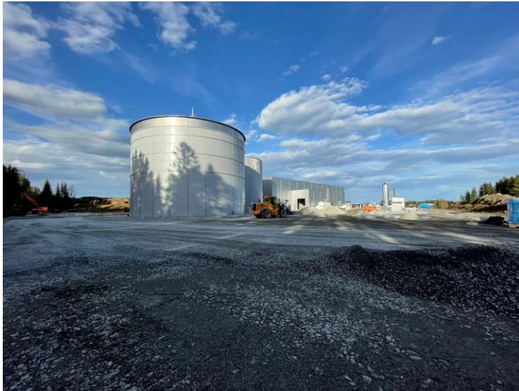
Rötrestlager närmast i bild
