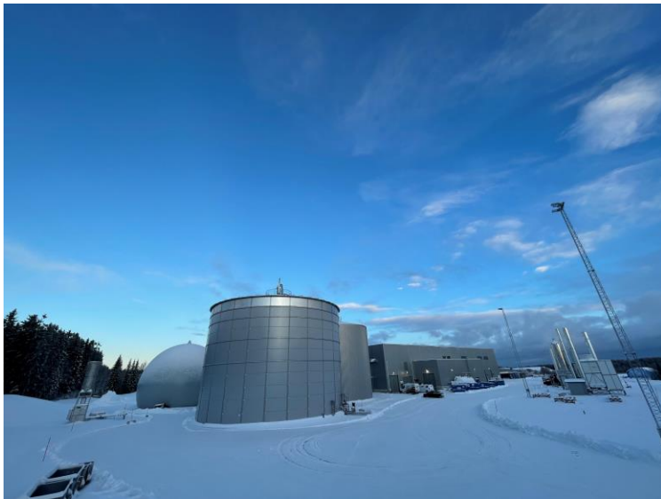
Rötgasanläggningen, bild tagen från sydväst
