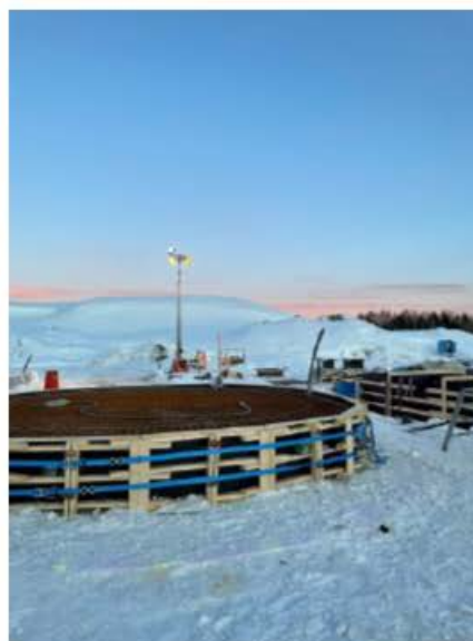
Inför gjutning av RRB
