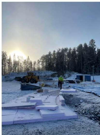
Isolering och armering av RRL
