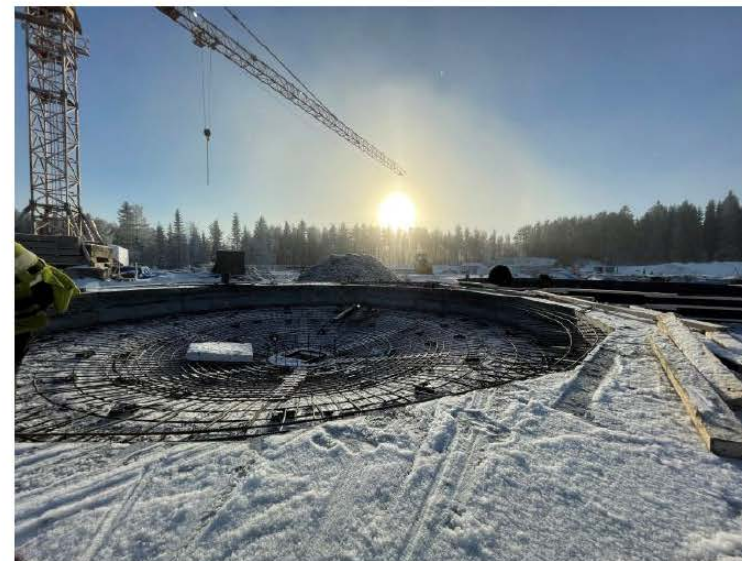
Armering av bufferttank flytgödsel
