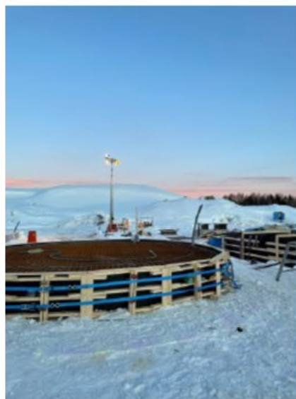
Inför gjutning av RRB
